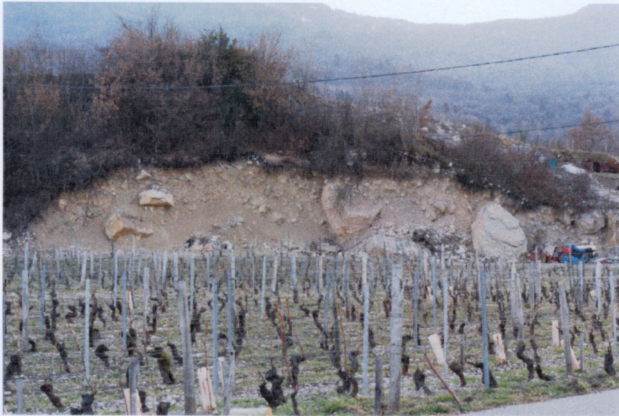
Figure 2. Aménagement d'une parcelle viticole au dépend d'un mollard. La coupe montre la grande hétérogénéité des matériaux glissés lors de l'éroulement.
